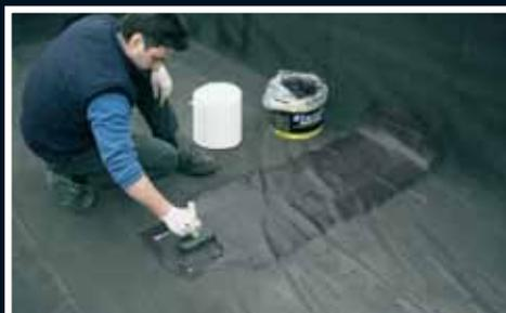
Tipico esempio di riparazione di saldatura di testa fra due teli di Guaina bituminosa eseguito con **ElastiK** e **Supporto Antifessura** in rotoli da 25cm di altezza
