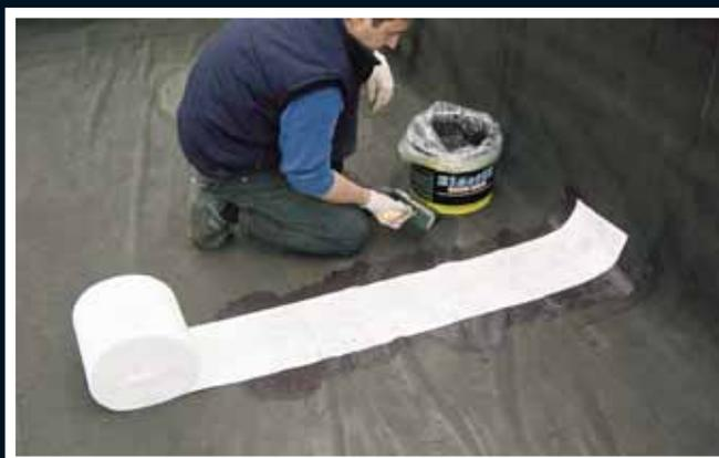
**Incollare con l'ElastiK il Supporto Antifessura** (tessuto non tessuto in poliestere da 100 g/m<sup>2</sup> usando il rotolo da 25 cm di larghezza) **nel centro della saldatura da riparare**
