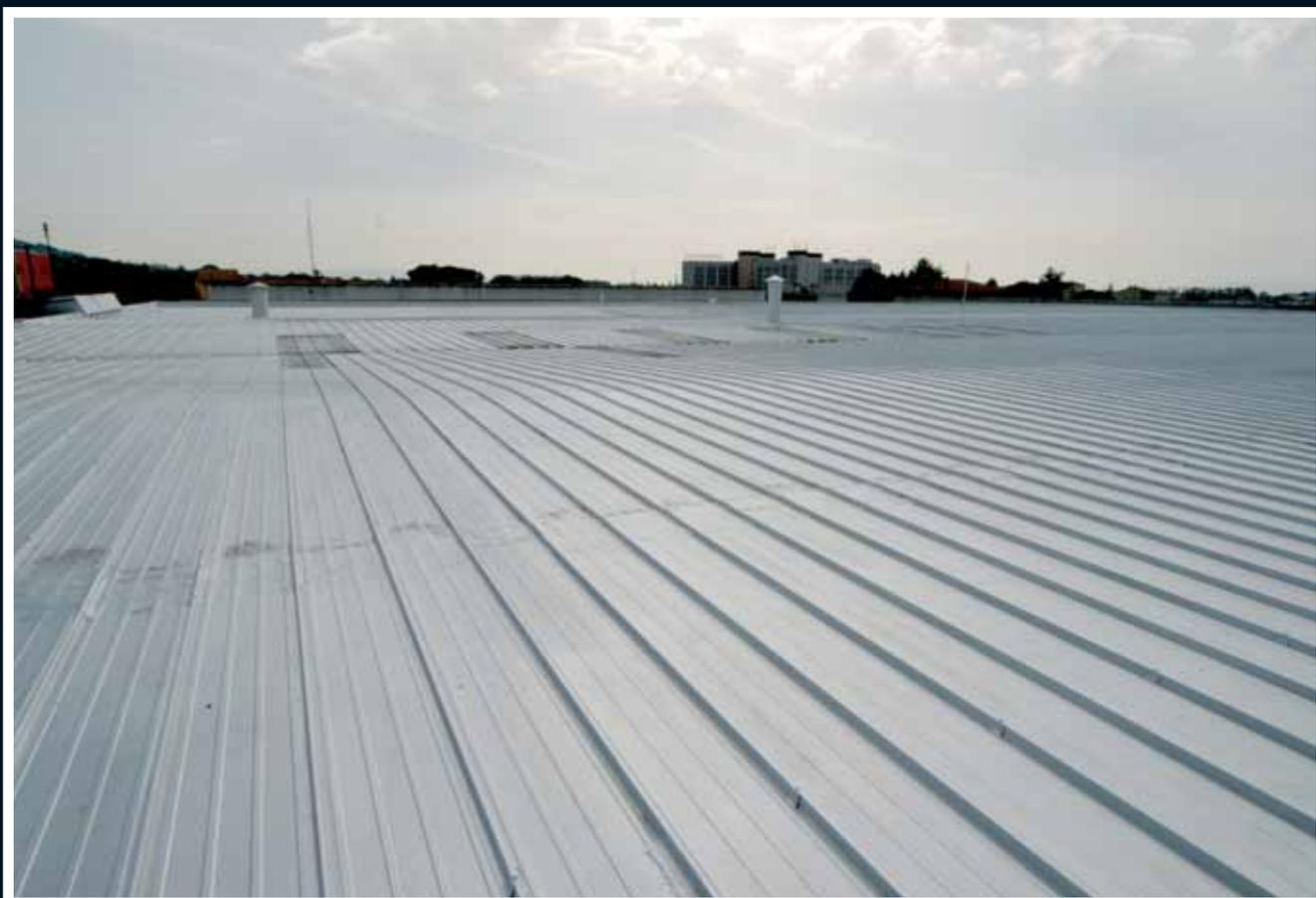
**Aspetto della copertura metallica finita dopo il trattamento realizzato con una mano di vernice all'alluminio tipo *Allumisol 12/14* steso dopo 20 giorni dalla seconda mano di *ElastiK*** (applicazione a spruzzo con un consumo totale di 200 g/m<sup>2</sup>)
