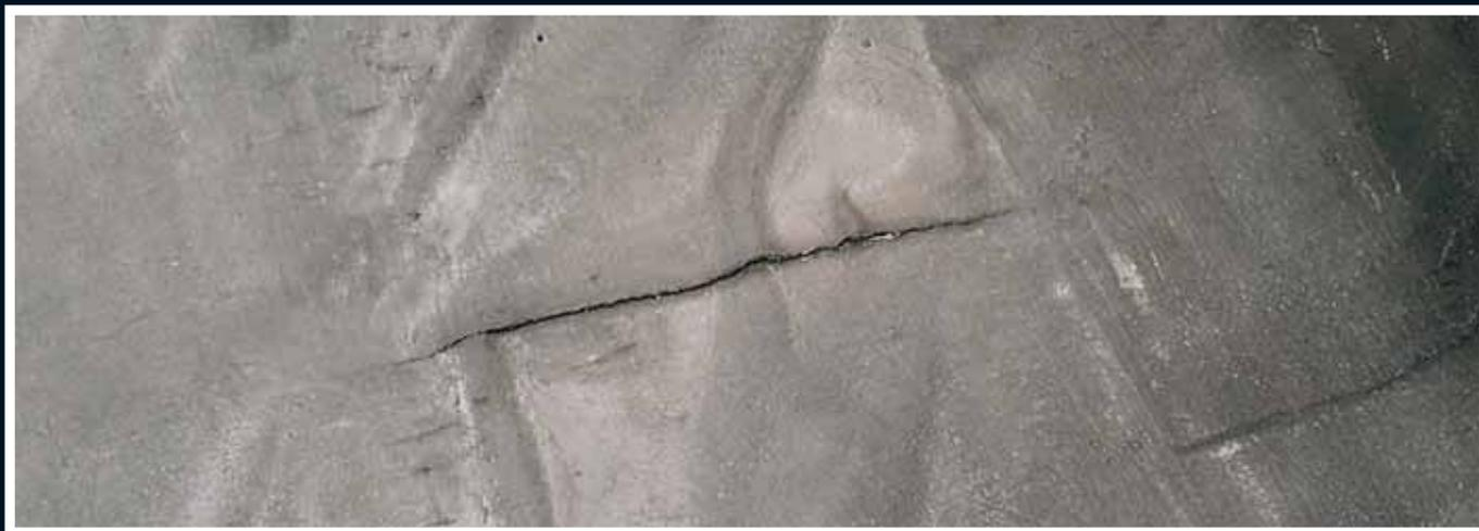
**Tipico distacco della saldatura fra due teli di guaina bituminosa in rotoli
