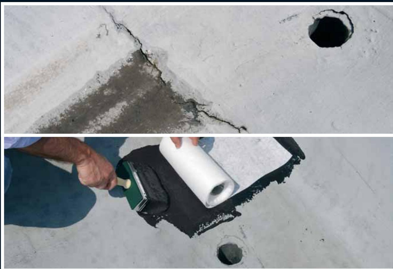
La riparazione impermeabile di fessure (nella foto si effettua la riparazione di una fessura su guaina bituminosa in prossimità del bocchettone di scarico usando **Elastik** e **Supporto Antifessura**)
