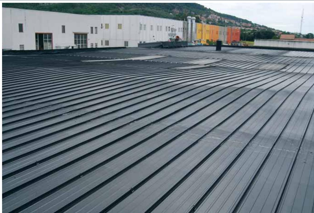
**Aspetto della copertura metallica dopo il trattamento realizzato con due mani di *ElastiK* stese a distanza di 48 ore una dall'altra** (applicazione a spruzzo con un consumo totale di 1 kg/m<sup>2</sup>)
