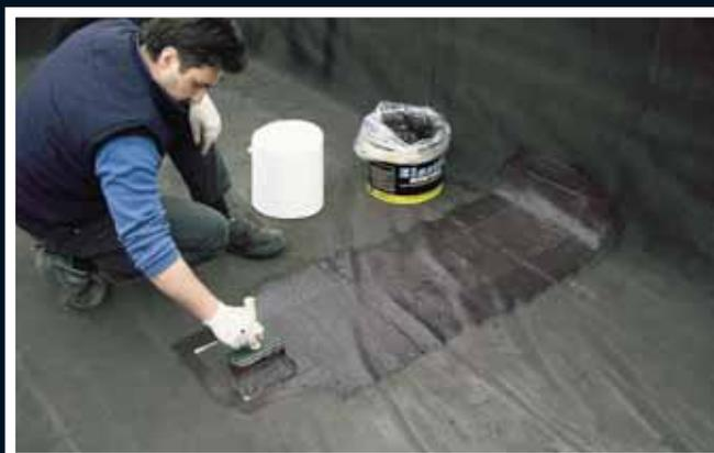
**Verniciare con una sola mano di Elastik il Supporto Antifessura fino a completa saturazione del suo spessore**
